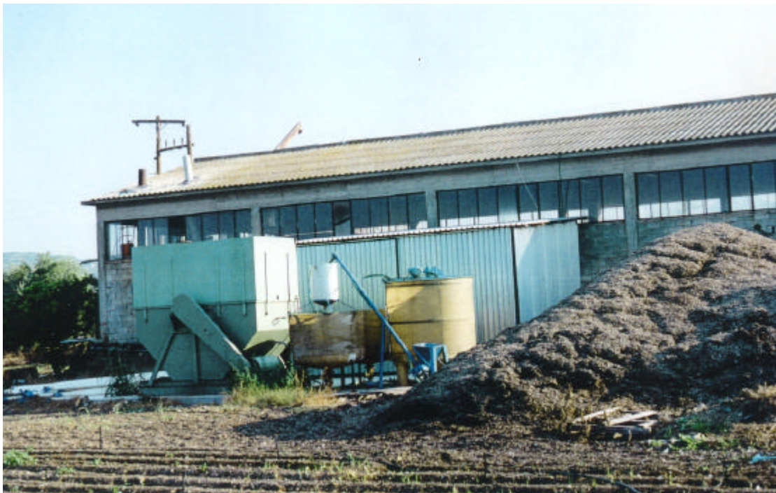
Installation pour la transformation des margines à engrais liquide à Romanos, Messina (Grèce)
