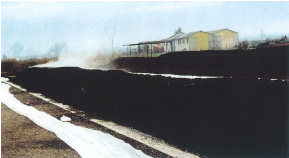
Installation de compostage à Kalamata (Grèce).
