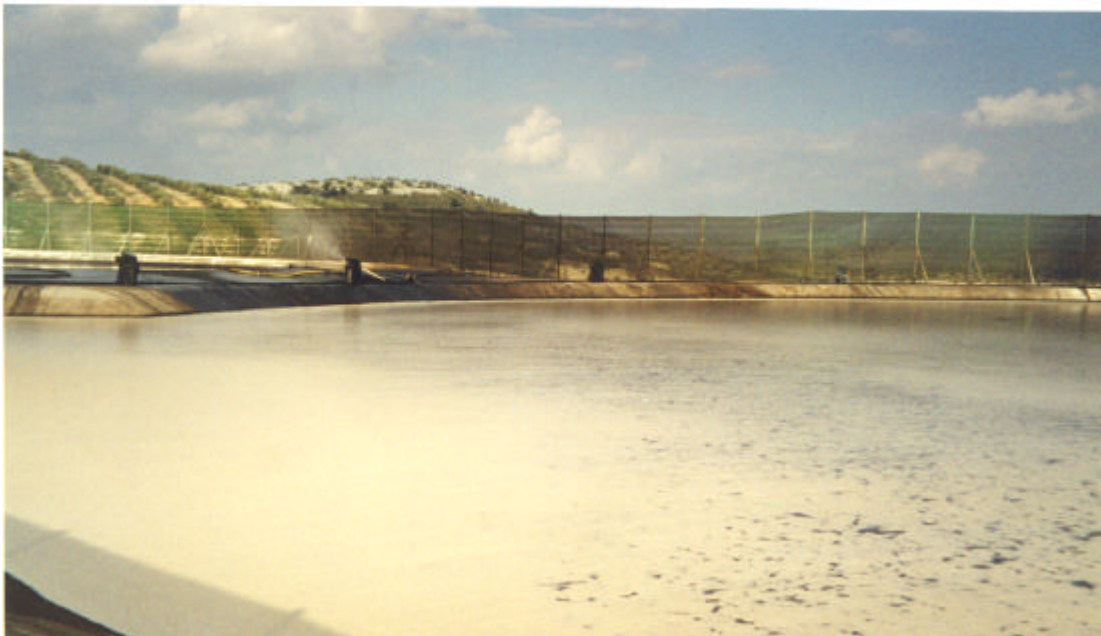
Bassin de stockage des margines
