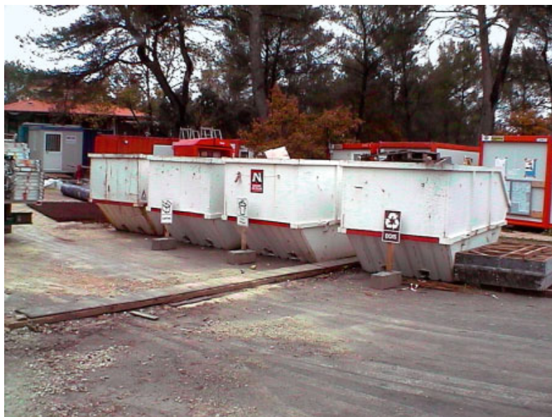
Tri des déchets de chantier sur le Petit Arbois
