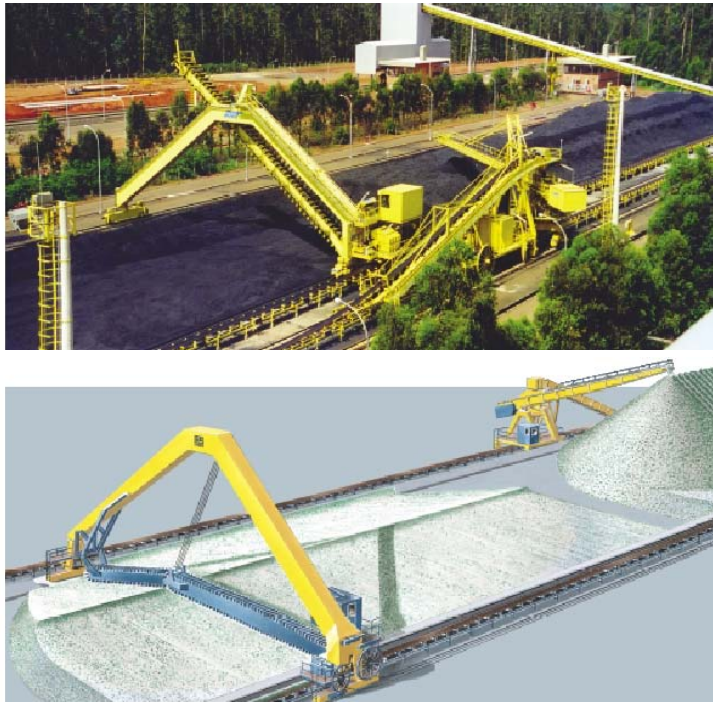
Figura 3.2.10. Método de almacenamiento en estratos. Recogedora pórtico.
