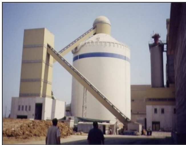
Figura 3.2.74. Silo de clínker.
