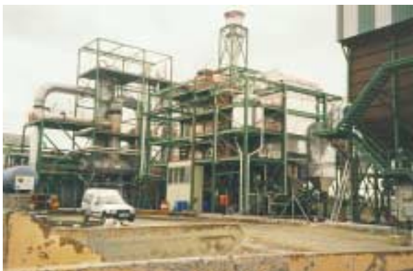
Planta de cogeneració elèctrica
