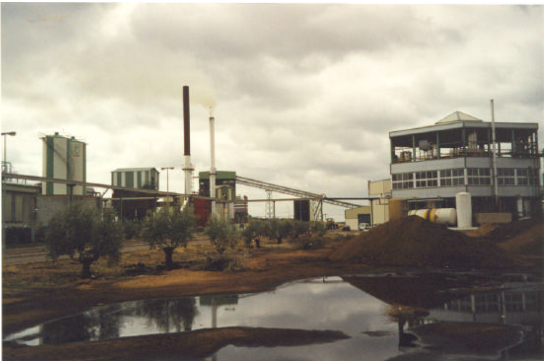
Oleícola El Tejar – Vetejar Extraction and cogeneration plants general view
