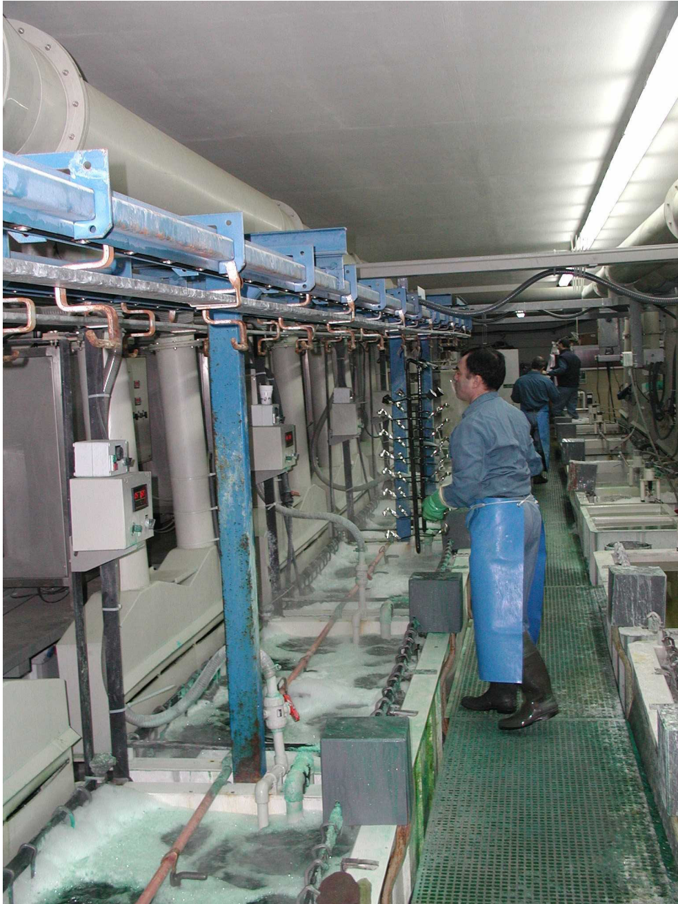
5 - Chaîne de suspension de châssis dans les bains de nickelage.
