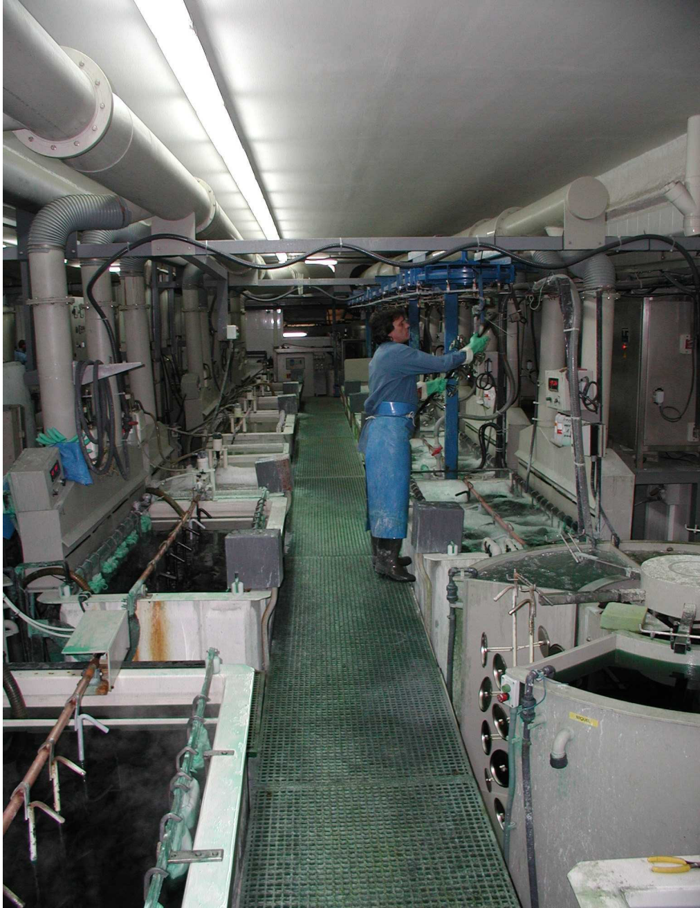
12 – Vue générale du passage avec plateaux de recueillement des égouttements au sol.
