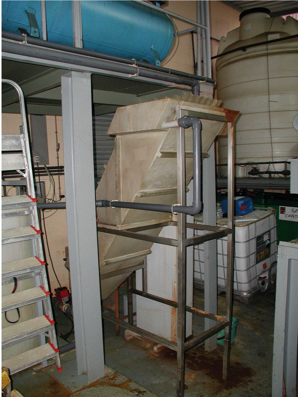
9 – Sédimenteur à lames pour concentrer les polluants avant l'évaporation.
